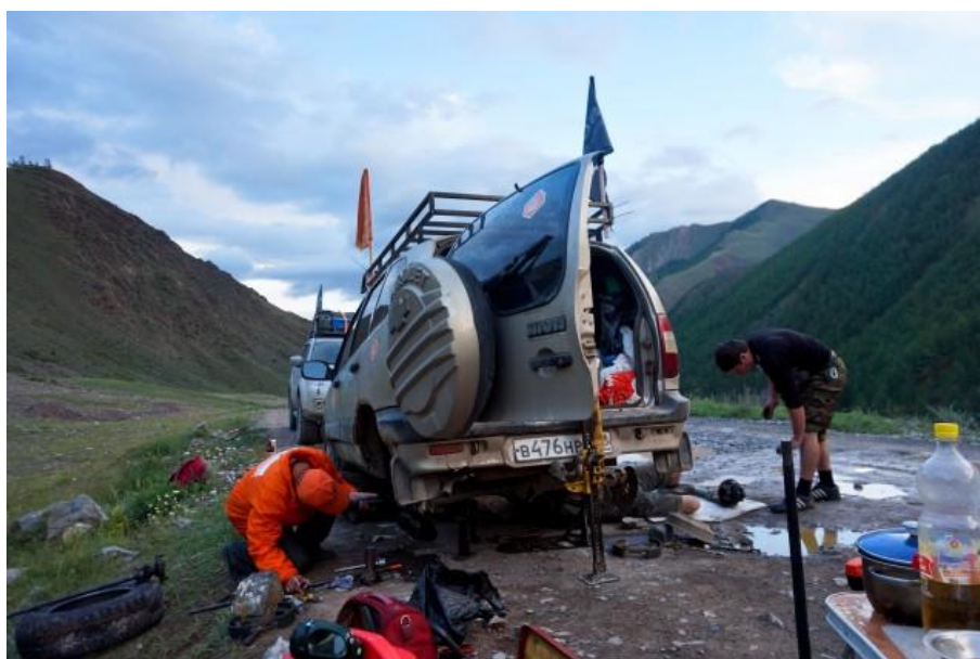
Фото № 94 Ремонт Шевроле Нивы – Алакаев Артур и Денис Грачев достают задний редуктор, Кучербаев Радис выбивает обойму подшипника полуоси
