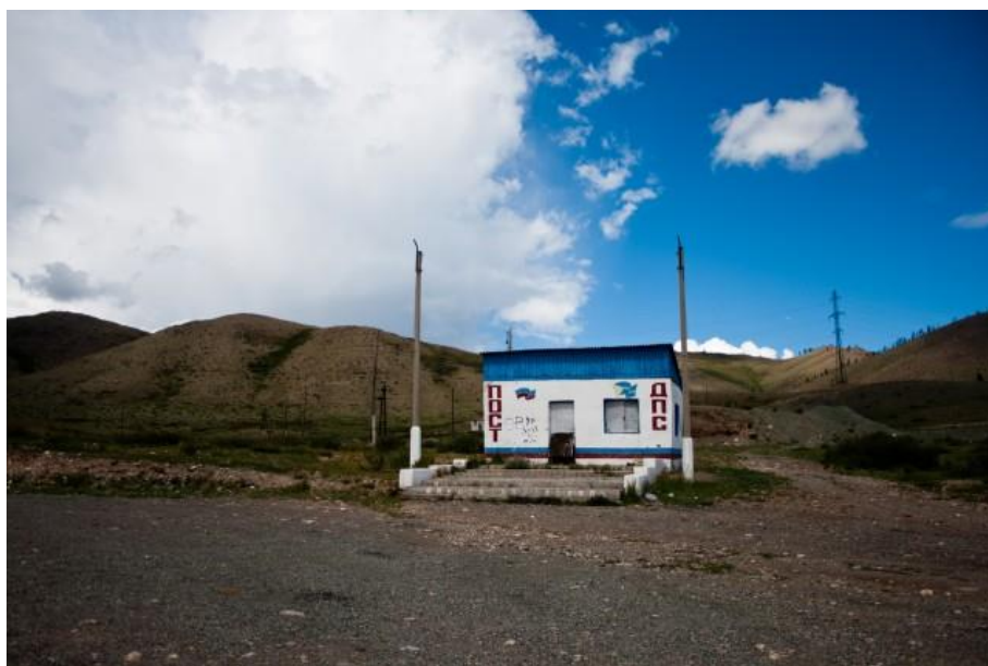
Фото № 104 Заброшенное здание ДПС дорога А163
