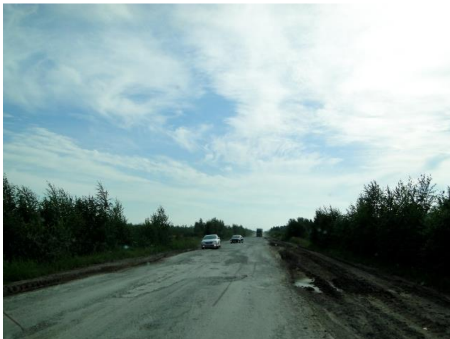
Фото № 6 Дорога Бердюжье
